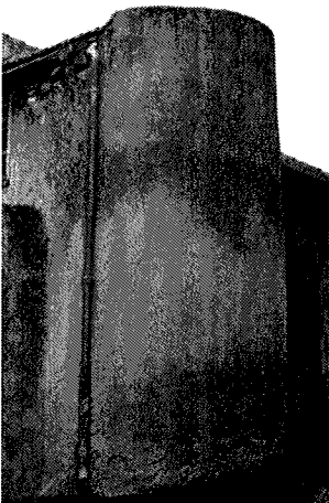
Tour boulevard des Ussels
