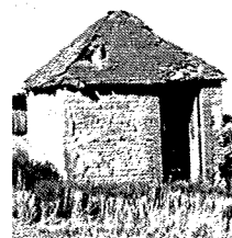
Les tonnes de vignes
