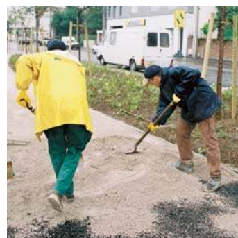
Etape 3 : Épandage et réglage du Stabex
