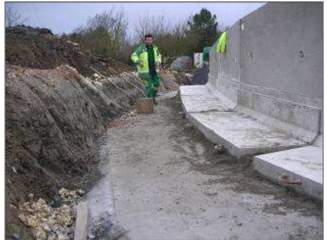
Murs posés sur lit sable ciment sec
