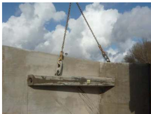
Manutention des murs en T nervurés avec les ancrs
