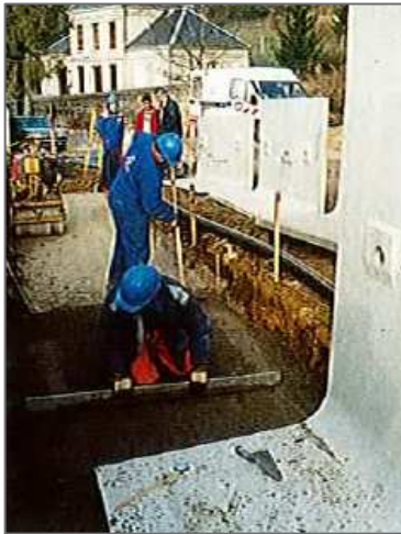
Réglage lit sable ciment sec
