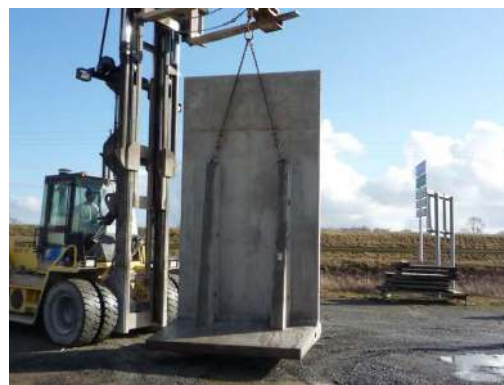
Manutention des murs en T nervurés avec un palonnier
