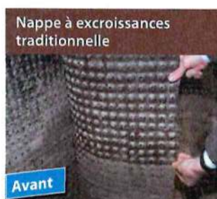
Risque de poinçonnement de certains revêtements d'étanchéité bitumineux par les alvéoles (alvéoles orientées vers le support).
